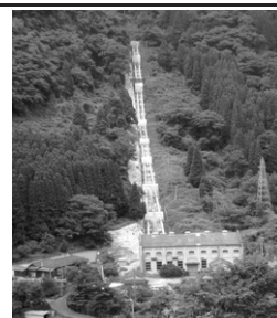
津留発電所(上益城郡山都町)
