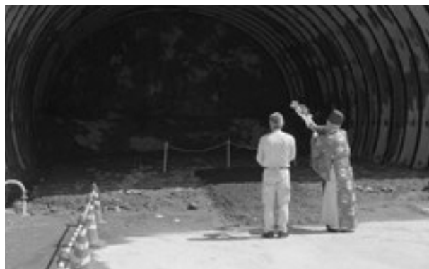
▲工事の安全を祈願する神職
