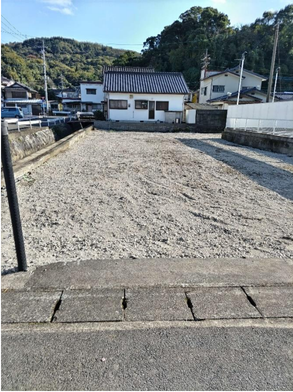
【国道3号側から撮影】
