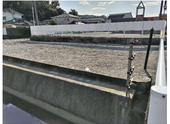
【北側（水路側）から撮影】
