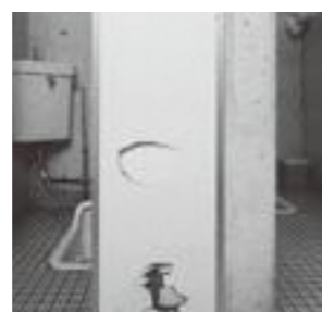
▲湯之見公園女子トイレ内の破損箇所
