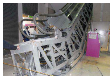
【エスカレーター落下】 （写真：国土交通省）
