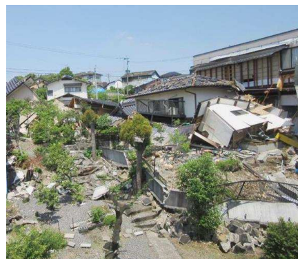
【平成28年熊本地震の被害状況】
