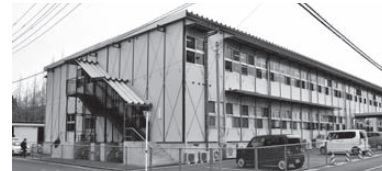
▼市役所仮庁舎
