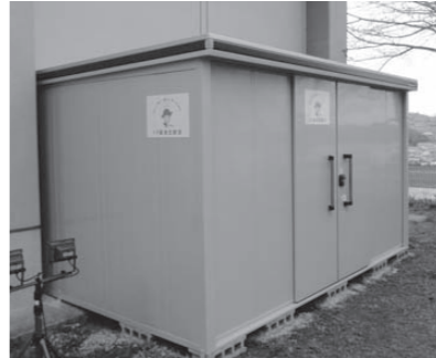
▼17区に整備された防災倉庫
