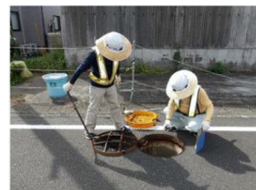
下水道マンホール点検の様子
