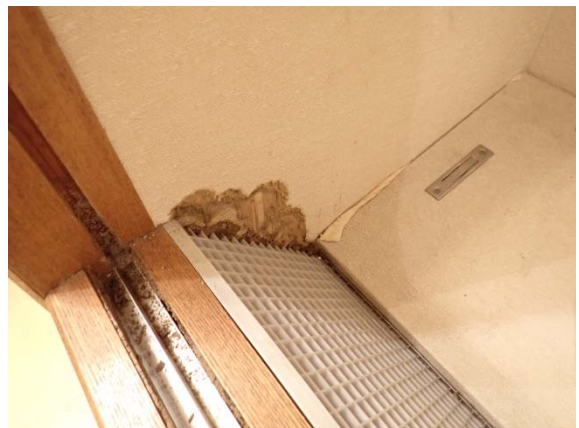
写真 2-1 非構造部材の腐朽状況（巾木の腐朽及び展示ケースの蟻害）
