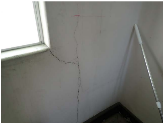
写真 2-1 内壁ひび割れ（階段室部分）
