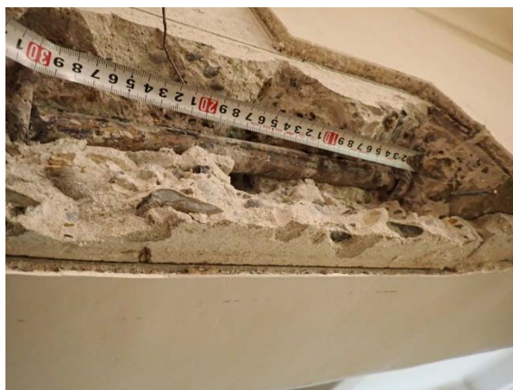
写真 2-2b 梁配筋状況
