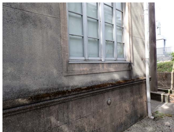
写真 2-1 基礎状況（大きな不同沈下は見られない）
