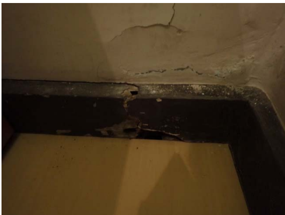
写真 2-1 非構造部材の腐朽状況（巾木の腐朽及び展示ケースの蟻害）
