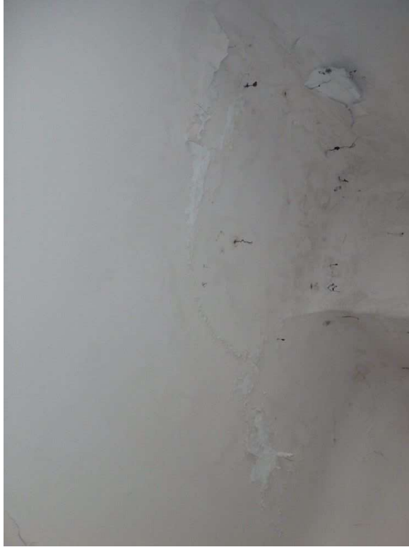
写真①1階天井 X-X5~X6 ・Y-Y1'~Y2、c-1 漏水跡
