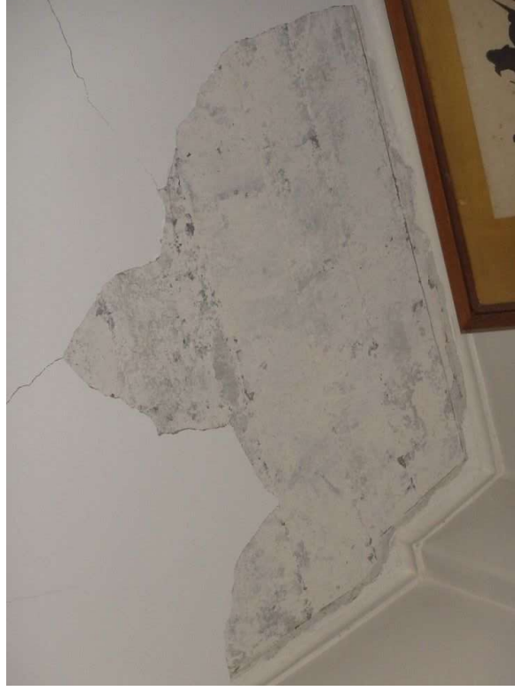
写真②2階天井 X-X3~X4 ・Y-Y3~Y4、c-2 仕上材の剥落
