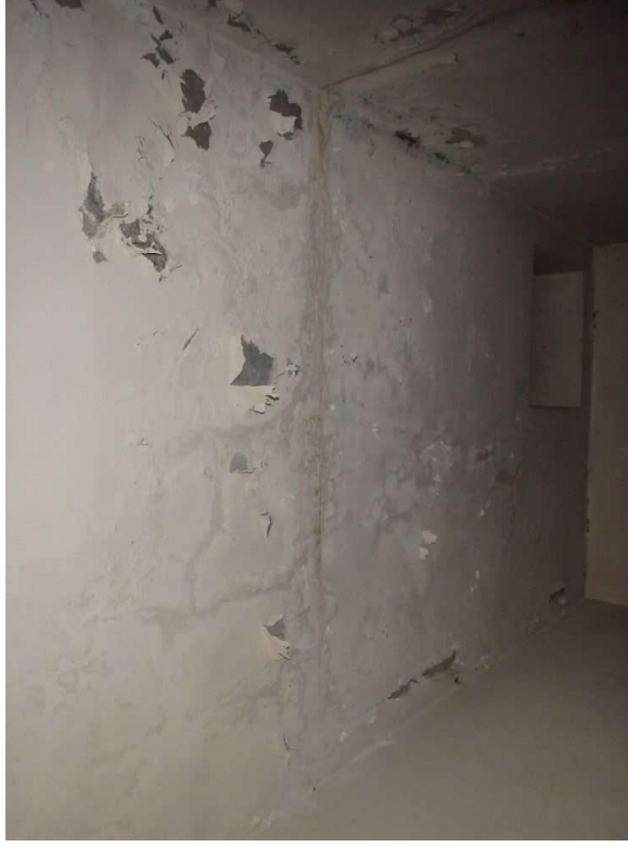
写真②2階天井 X-X3~X4 ・Y-Y3~Y4、c-2 仕上材の剥落
