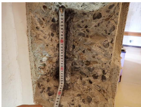
写真 2-2a 柱配筋状況
