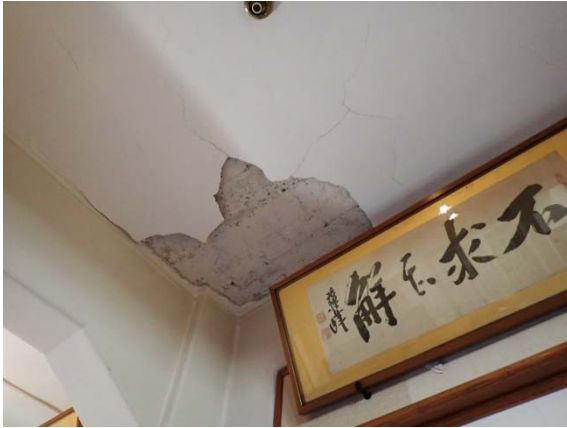
写真 2-1 天井剥落
