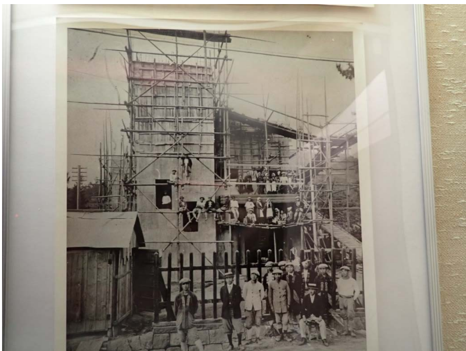
写真 1-4 建設時の様子
