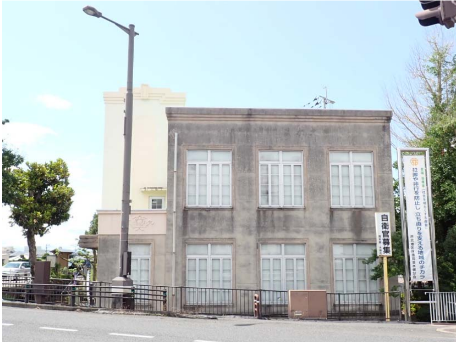
写真 1-1b 建物外観（東面）
