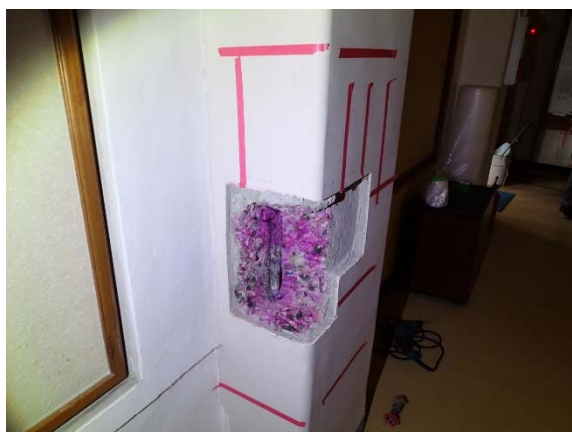
写真 2-2a 柱配筋状況
