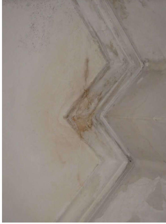
写真①1階天井 X-X5~X6 ・Y-Y1'~Y2、c-1 漏水跡
