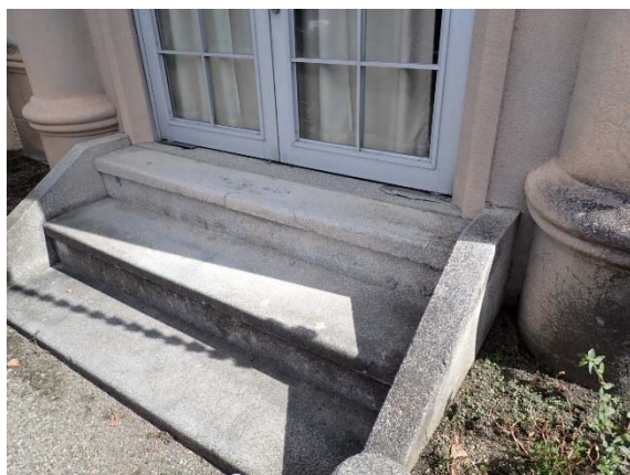
写真 2-1 基礎状況（大きな不同沈下は見られない）
