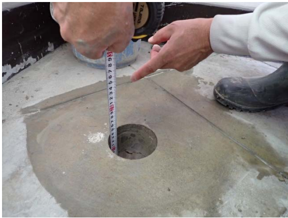
写真 2-2d 床コア抜き状況
