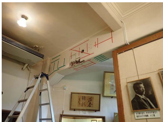
写真 2-2b 梁配筋状況
