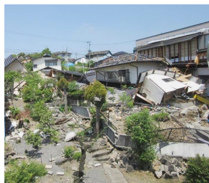
【平成28年熊本地震の被害状況】
