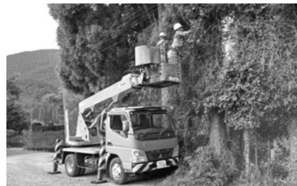
▲緑東中で高所作業車に乗り、鎌で枝を取り除く参加者ら
