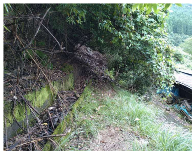
〈深川新屋敷地区農道〉
