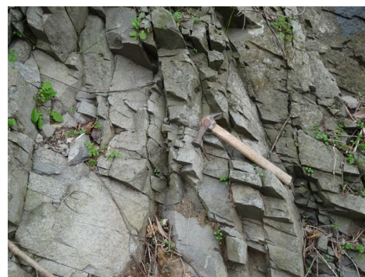
写真 10 大崎の旧水俣市営採石場の板状節理
