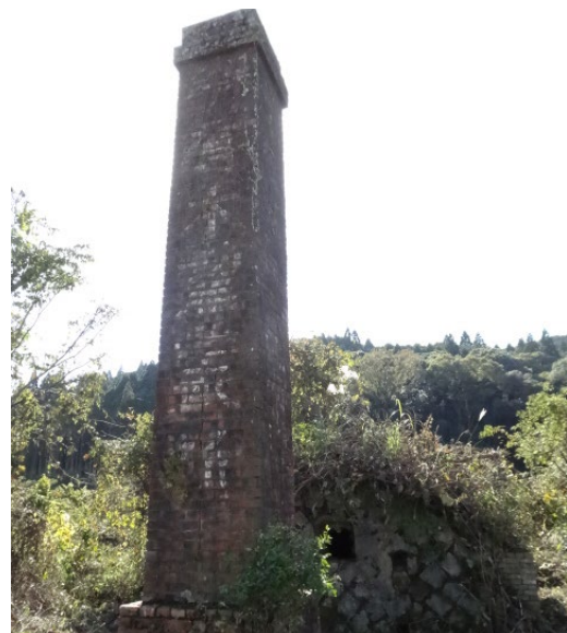
写真 28 日当野瓦工場の窯と煙突
