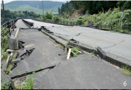
1_倒壊した建物 2_避難所での支援のため派遣されている保健師と看護師 3_避難所 4_完成した仮設住宅 5_応急危険度判定の結果を示す張り紙 6_損壊した大切畑大橋 7_地表に現れた断層
