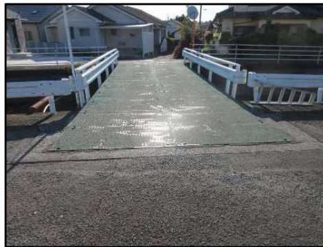
〈市道 塩浜・丸島町線〉 グランド第二橋：補修
