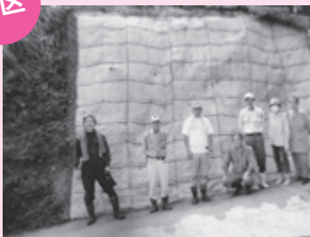
小津奈木公民館 法面災害復旧
