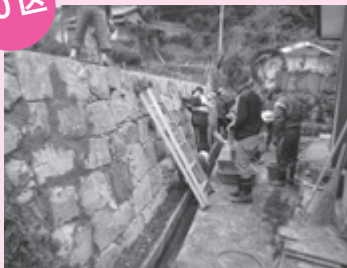
集グラウンド法面強化
