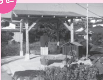
防災井戸建屋建設
