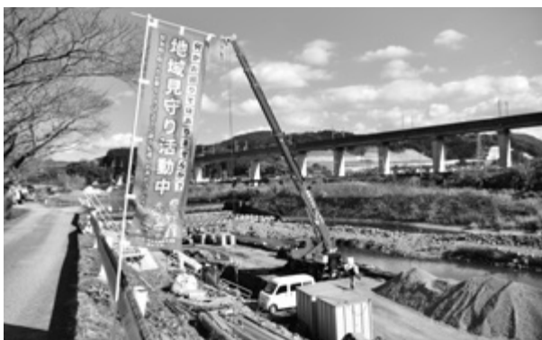
▲市内事業所、(株)坂田建設の作業現場に設置されている様子
