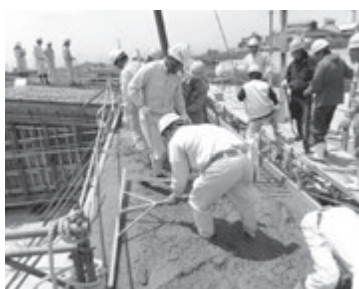
▲快適な暮らしを保つため、安全かつ正確に施工する作業員の皆さん
