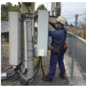
▲太陽光計測装置の取付作業
