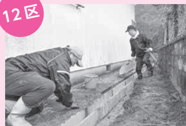
石坂川集会所の雨水排水対策
