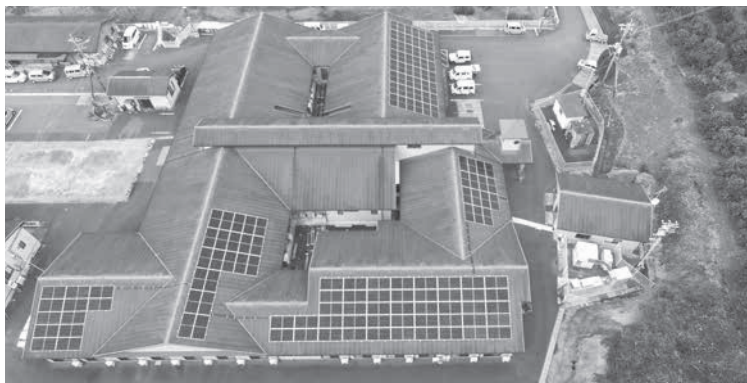
▲2つの施設の屋根に合計224枚の太陽光パネルと2台の蓄電池を設置。年間63.5tのCO 2 を削減できます。
