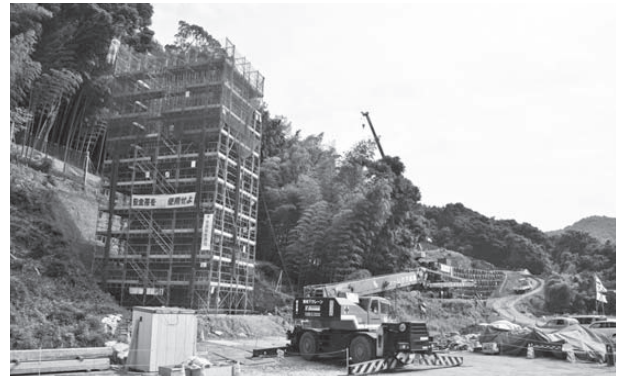
▲津奈木ICから水俣IC間の、小津奈木第2橋の現場
