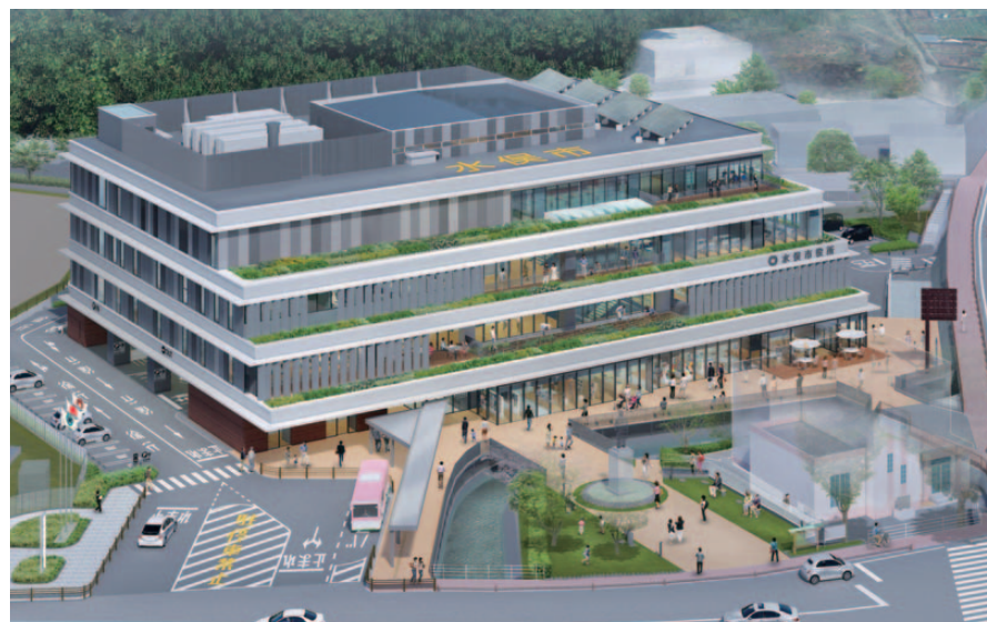
（写真上）ドローンで撮影した2月28日現在の新庁舎工事の様子 （写真下）市役所新庁舎の完成イメージ
