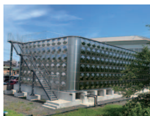
▲第二水源貯留施設 1,500 m
