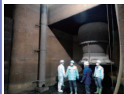
▲丸島ポンプ場点検作業
