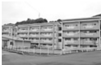
▲写真は白浜市営住宅
