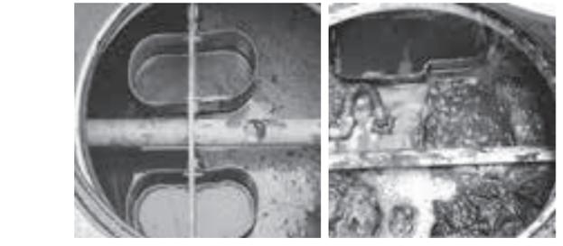
(左) 適切に管理された浄化槽の内部。(右) 無管理の浄化槽。沈殿した汚物を取り除いていなかったため、汚物でいっぱいになっています。
