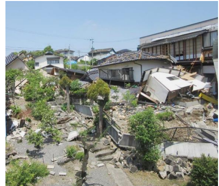
【 平成 28 年熊本地震の被害状況 】
