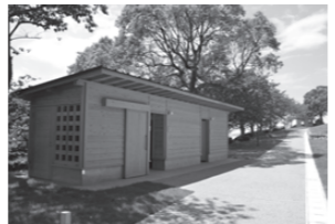
改修した トイレ
