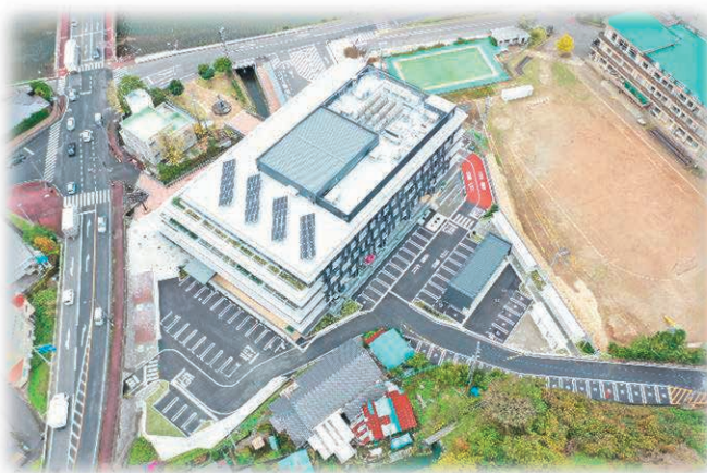
太陽光パネル（市庁舎）
