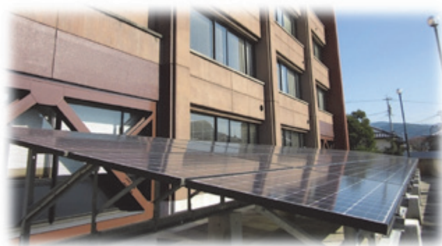
太陽光パネル（公民館・図書館）
