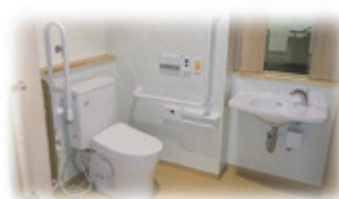
改修後のトイレ
