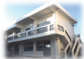
改修後の外壁
