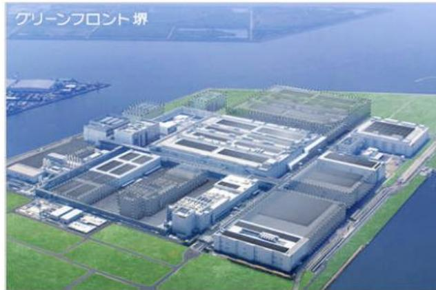
シャープが中心となり堺市に建設された低炭素型コンビナート。エネルギーの統合制御や棟間輸送の効率化、LED照明等の省エネ技術により、従来工場と比較してCO2排出原単位を35%削減。また、建物屋上への太陽光発電システム導入も予定。
