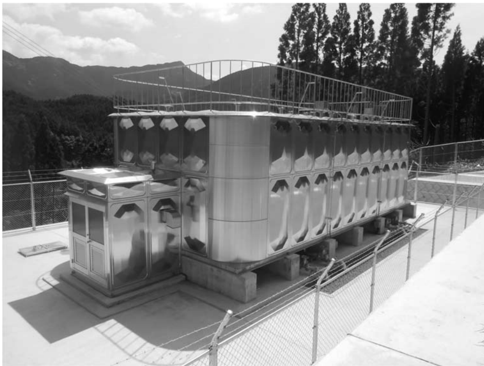
ひご山配水池（水俣市市渡瀬 2015 年度完成）
