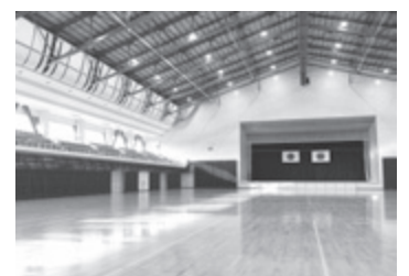
空調整備が完了した大アリーナ
