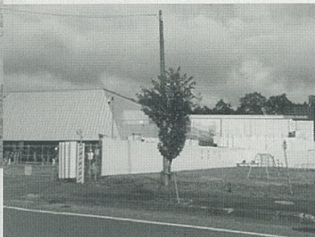
(建設中の義務教育学校)
