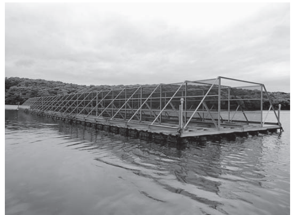
西浦地区浮消波堤
