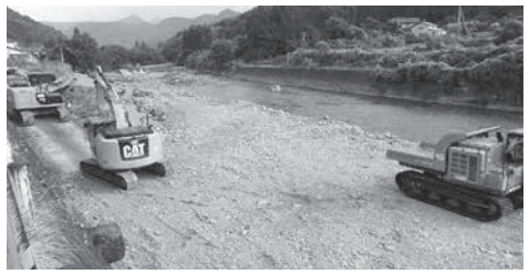
深川河川工事風景
