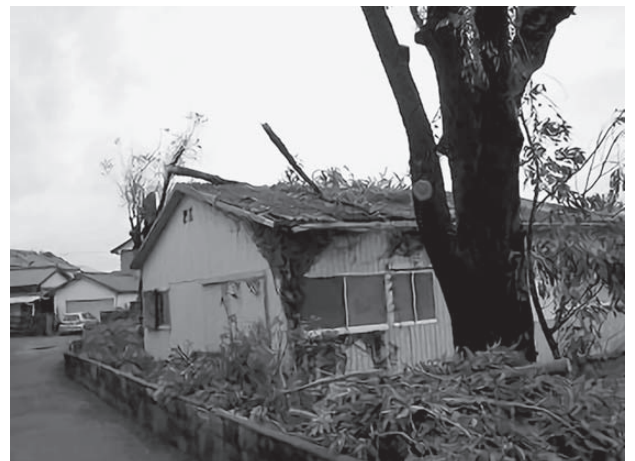
第二中学校体育倉庫
