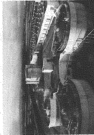
▼下水浄化工場 (H13) 冷暖房用の冷温水発生機
