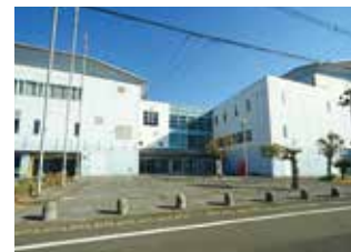
水俣市立総合体育館
