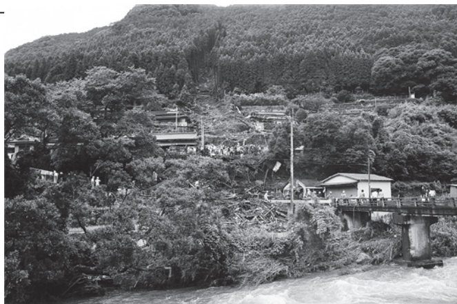
深川新屋敷地区土砂災害遠景
