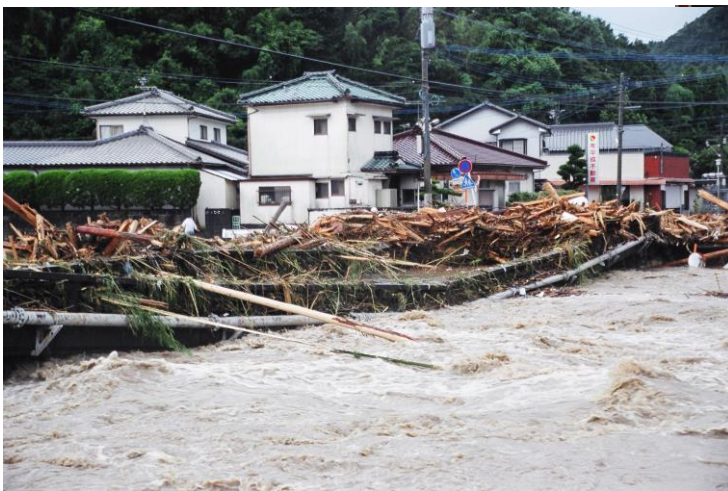
写真 流木などにより崩壊した鶴田橋
