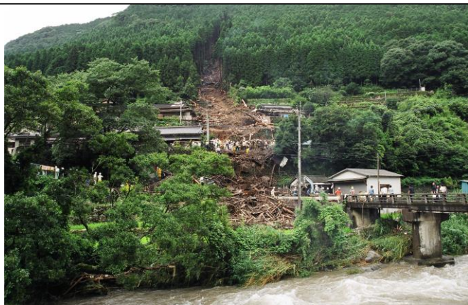
深川新屋敷地区土砂災害遠景
