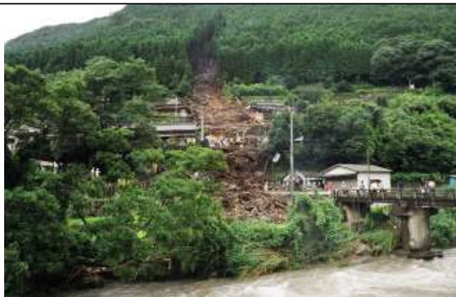
深川新屋敷地区土砂災害遠景
