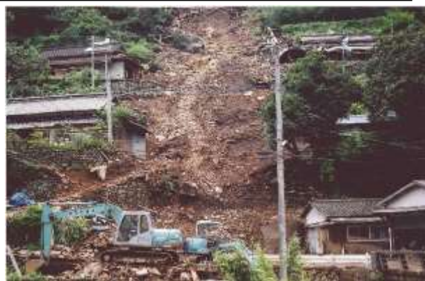
深川新屋敷地区土砂災害近景
