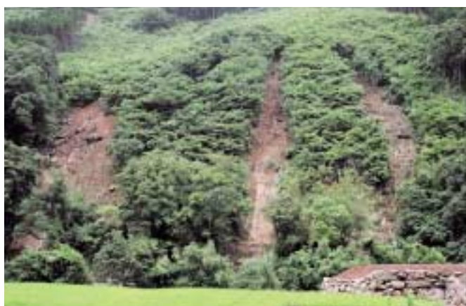
写真-9 このようながけ崩れも多数発生した
