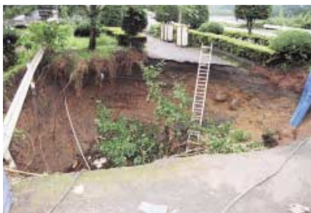
写真-10 道路や歩道の陥没も多数発生した
