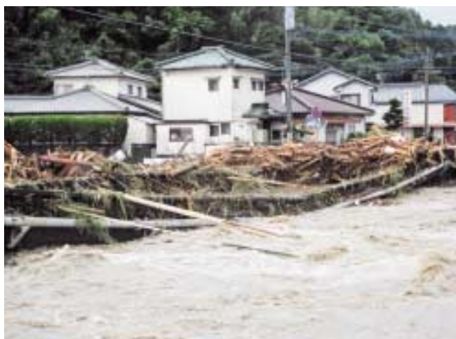
写真-7 流木などにより崩壊した鶴田橋
