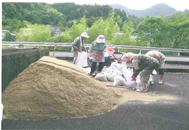
地域住民による詰込作業
